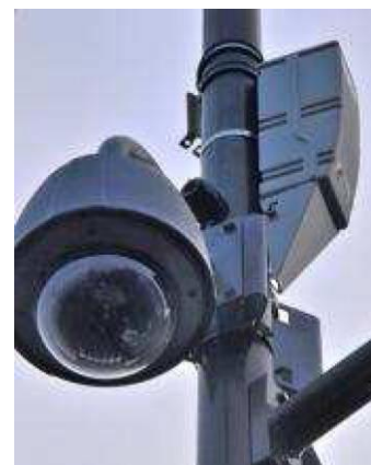
Außenmontage am Mast
